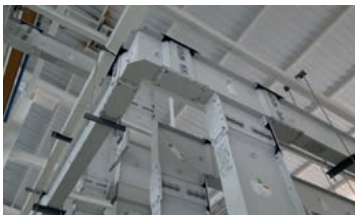
Exemple de système de canalisations Legrand
