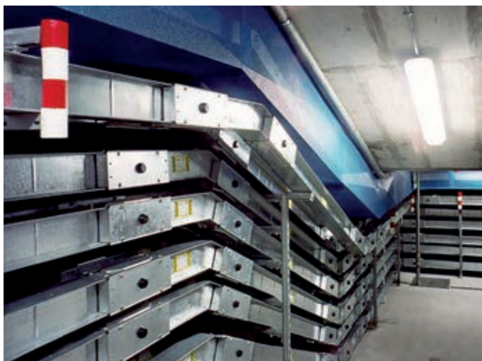
Exemple de distribution de puissance élevée
