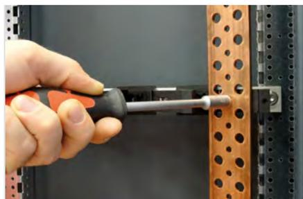
**!** Positionner les rondelles plastique fournies entre les barres et les supports pour les dimensions de barres de dimensions 50 mm x 5 mm et 63 mm x 5 mm.
